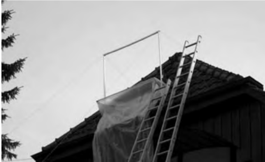
Harfenfalle und Oberwiler Feuerleiter
