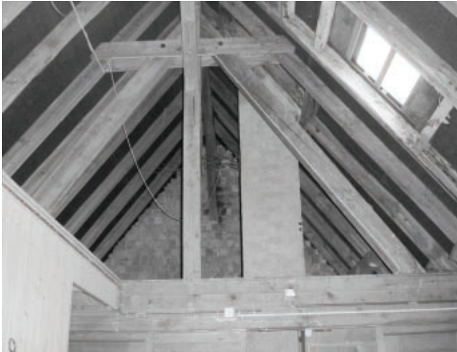
Der Dachstock der Käserei Oschwand vor dem Einbau eines Zwischenbodens
