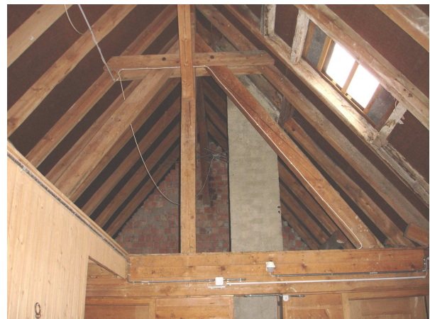
Der Dachstock vor Einbau eines Zwischenbodens Foto: C. Eicher
