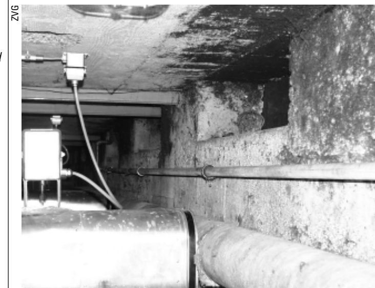
Der Kellerraum im Fabrikgebäude bei Wimmis
